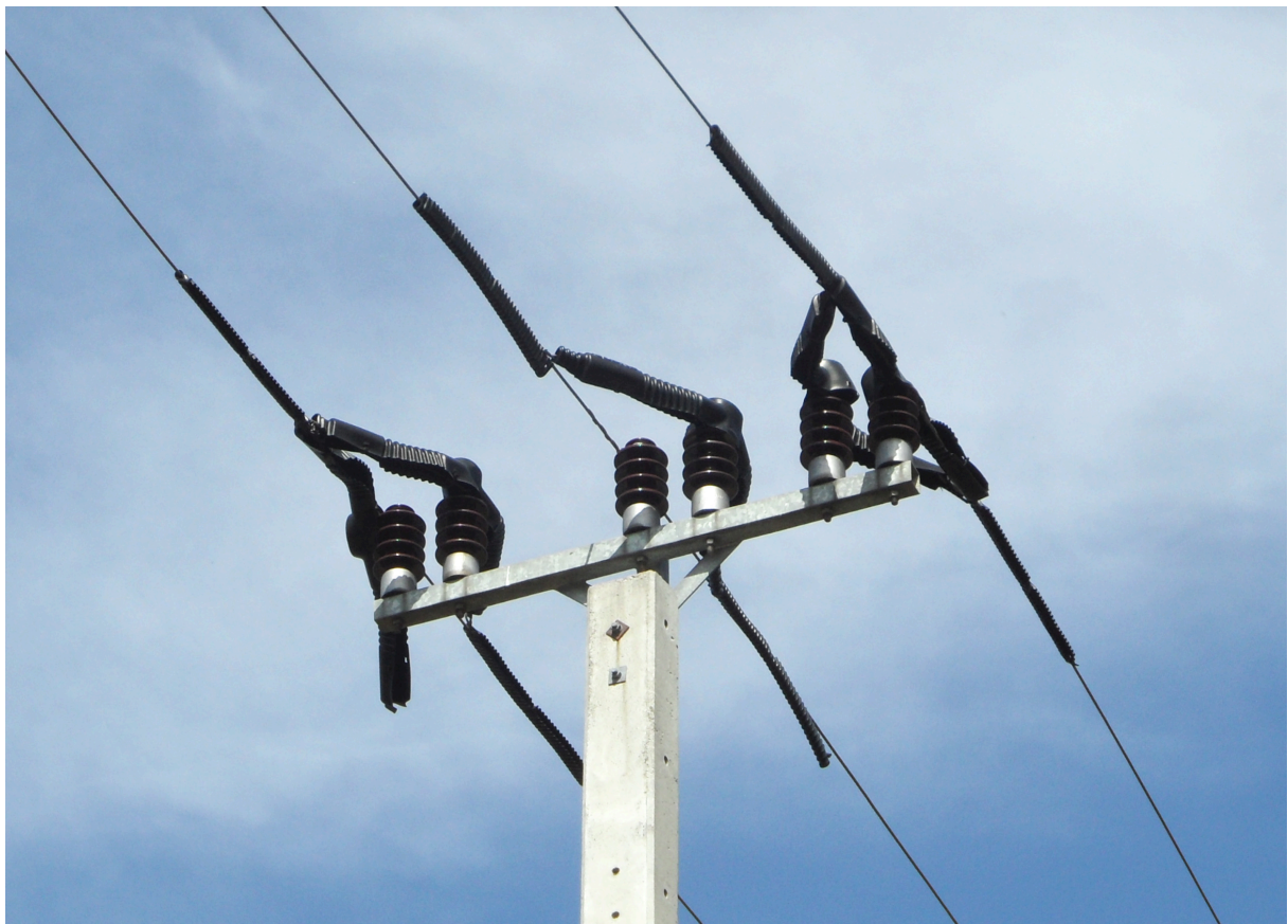
8. kép: szerelvényhiány eredményeként hiányosan, hibásan szerelt burkolatok korai avulása
