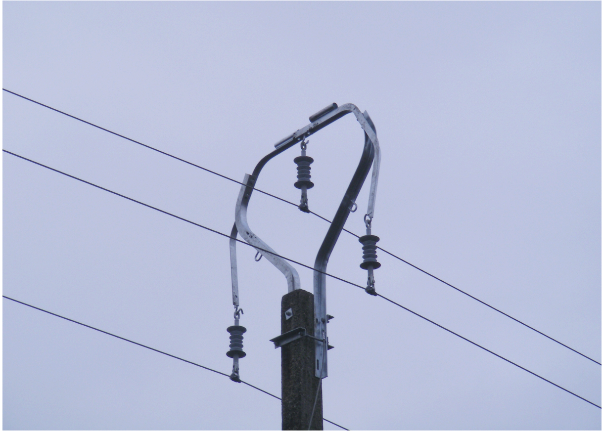
9. kép: a Kerecsen LIFE+ projektben MFK1 típusú fejszerkezettel szerelt oszlop (2014. 11. hó)
