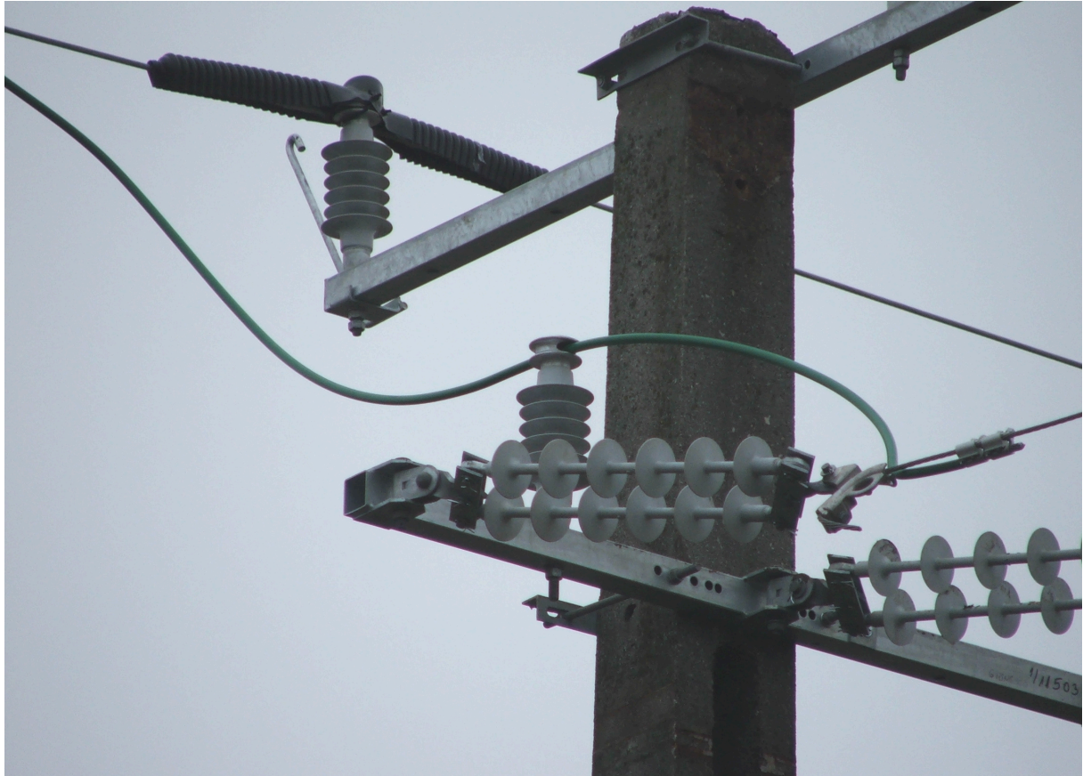
15. kép: a burkolt vezeték nem érintkezhet eltérő potenciálú fémfelülettel, mert burkolata károsodik
